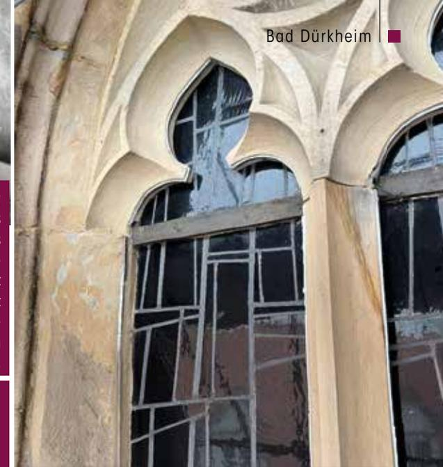
Die Arbeiten an der Schutzverglasung haben begonnen. Im Bereich des Chores sind die Kunststoffscheiben vor der kunstvollen Verglasung entfernt. Als nächstes werden die Scheiben ausgebaut um überarbeitet zu werden.
