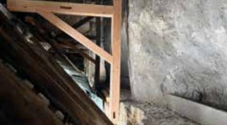
Das neue Binderwerk stellt die Verbindung zwischen Obergadenwand des Hauptschiffes und nördlicher Außenwand her und bildet das neue Auflager für die Mittelpfette des nördlichen Seitenschiffes. Die Gewölbestruktur ist gut erkennbar, nachdem der Dachboden gereinigt wurde. Die losen Mauersteine auf der Außenwand wurden entfernt und werden durch einen Steinmetz wieder ergänzt.
